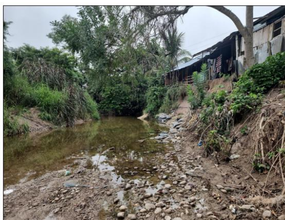
FIGURA N°02: TRAMO CRITICO DE LA QUEBRADA, DONDE SE EVIDENCIA LA VULNERABILIDAD DE LAS VIVIENDAS DE MATERIAL RUSTICO PROPENSAS A DESPLOMARSE POR LA EROSION QUE TIENE EL BORDE DE LA RIBERA.
